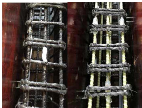
Slika 3.8 – Zaštićene mjerne trake i plastični distanceri sa armaturom u oplati
