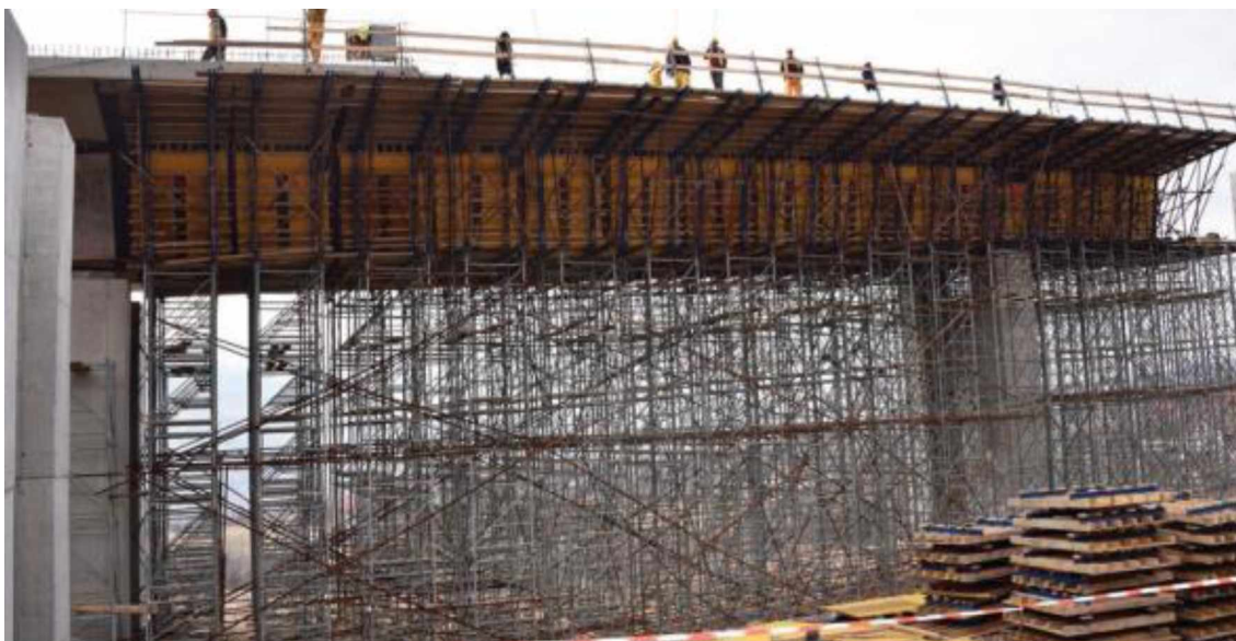
Slika 4.15 Čelična cijevasta skela za betoniranje rasponske konstrukcije [A. Bogdan (2017): „Gradi se preostali dio koridora V.c kroz BiH“, GRAĐEVINAR 69 (2017) 6]
