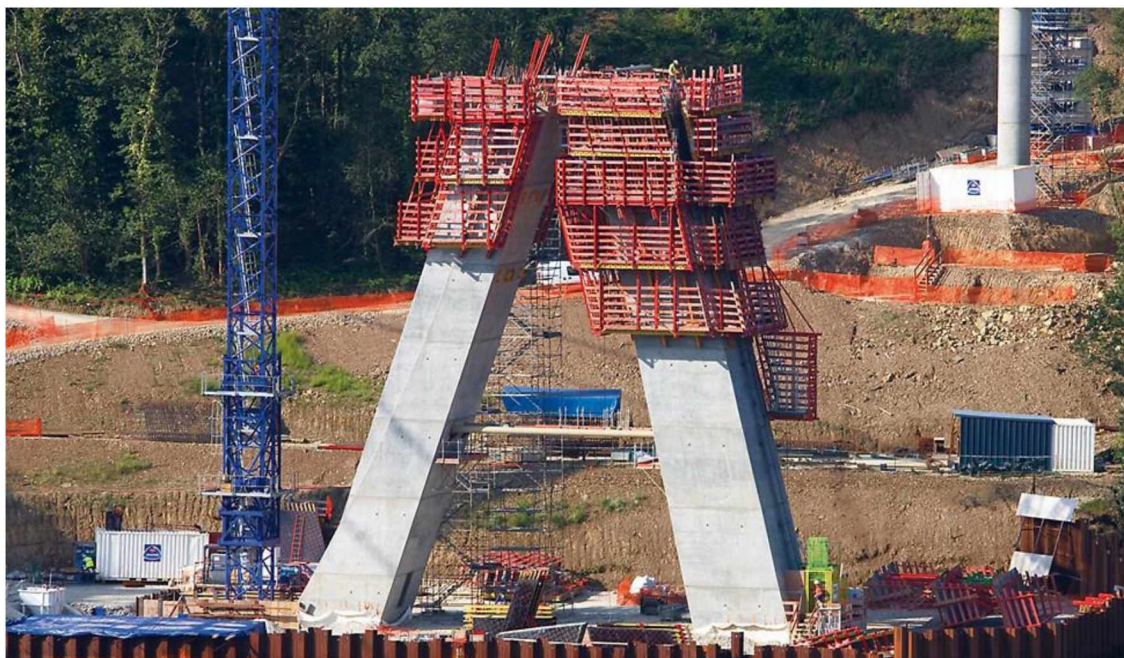
Slika 4.20 Betoniranje stubova sa kliznom skelom
