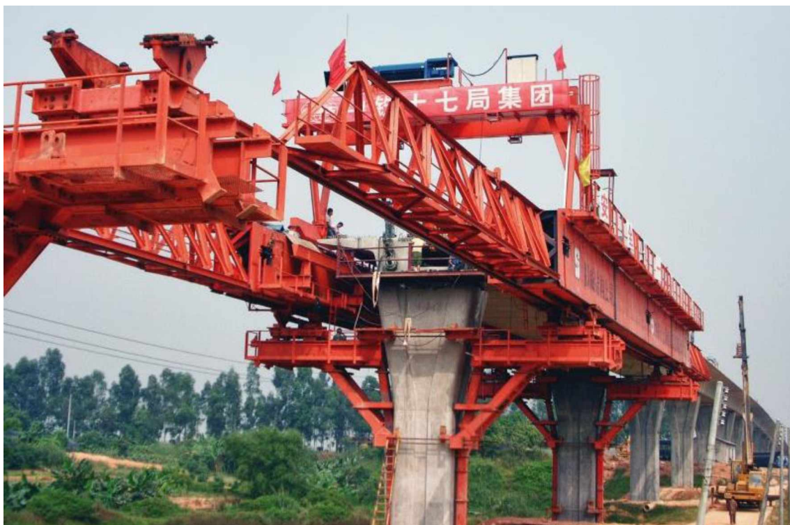
Slika 4.18 Pokretna čelična skela
