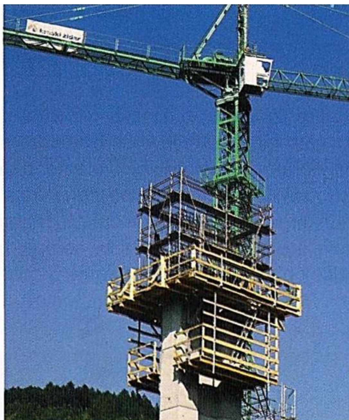
Slika 4.19 Betoniranje stubova sa pokretnom oplatom (Kovačević, 2018)
