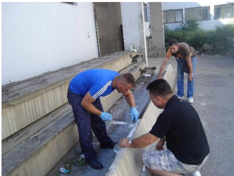
Slika 4.9 Nanošenje sloja lijepka na karbonsku traku
