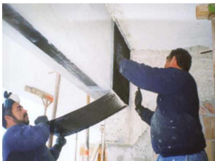
Slika 2.3 Ojačanje greda i ploča na savijanje i smicanje [19]
