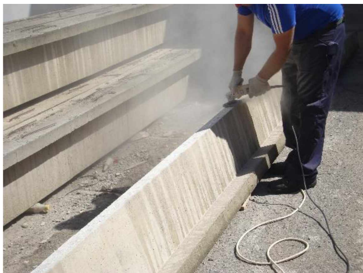
Slika 4.6 Priprema betonske podloge (brušenje)
