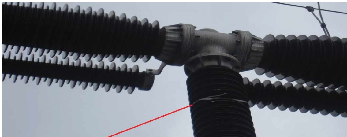
Slika 20. Oštećenje kondenzatora na polu LB i potpornom izolatoru na fazi LB polje T3.
