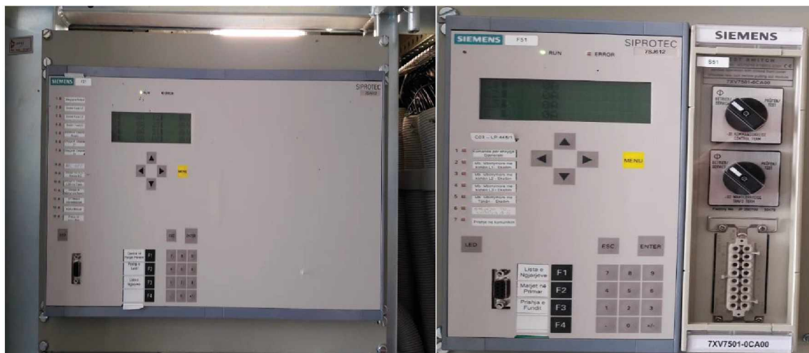
Slika 21. a) Merni releji (distantni) tipa siemens 7SA612, b). Merni releji (prekostrujni) tipa siemens 7SJ612.
