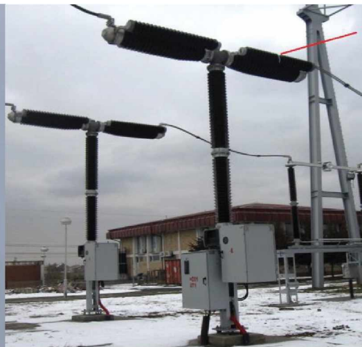
Slika 19. Oštećenje kondenzatora, polje T2.
