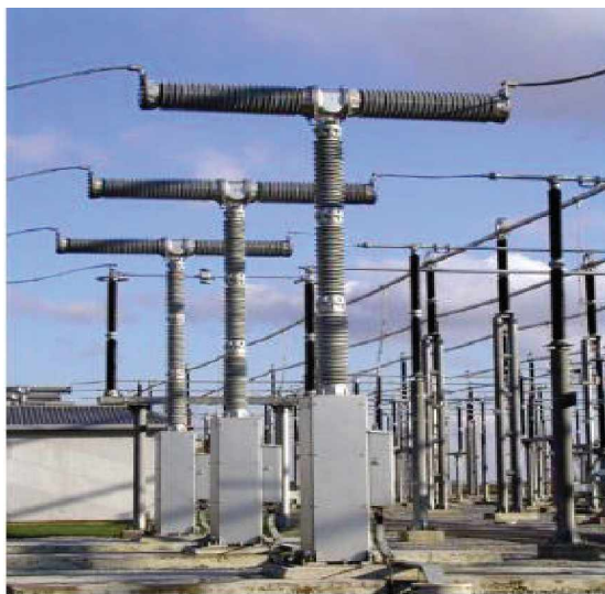
Slika 4. Prva generacija SF6 prekidača.
