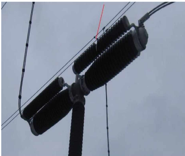
Slika 18. Oštećenje kondenzatora na polu LB, polje T1.
