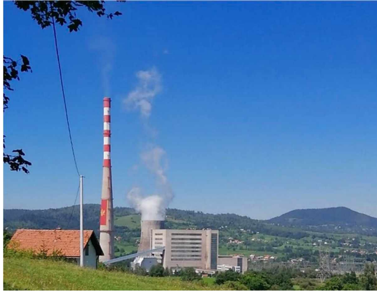
Slika 10. Postrojenje Termoelektrane „Pljevlja“ (lična arhiva).
